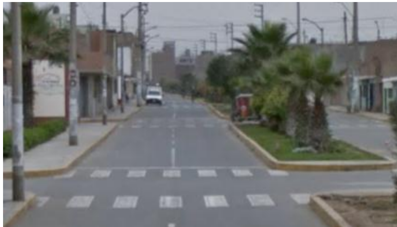
Foto N° 3.4.2.3.B Vista de la zona homogénea 3a de la ciudad de Huaral, cuyo proceso de consolidación es más lento y predomina el uso residencial
