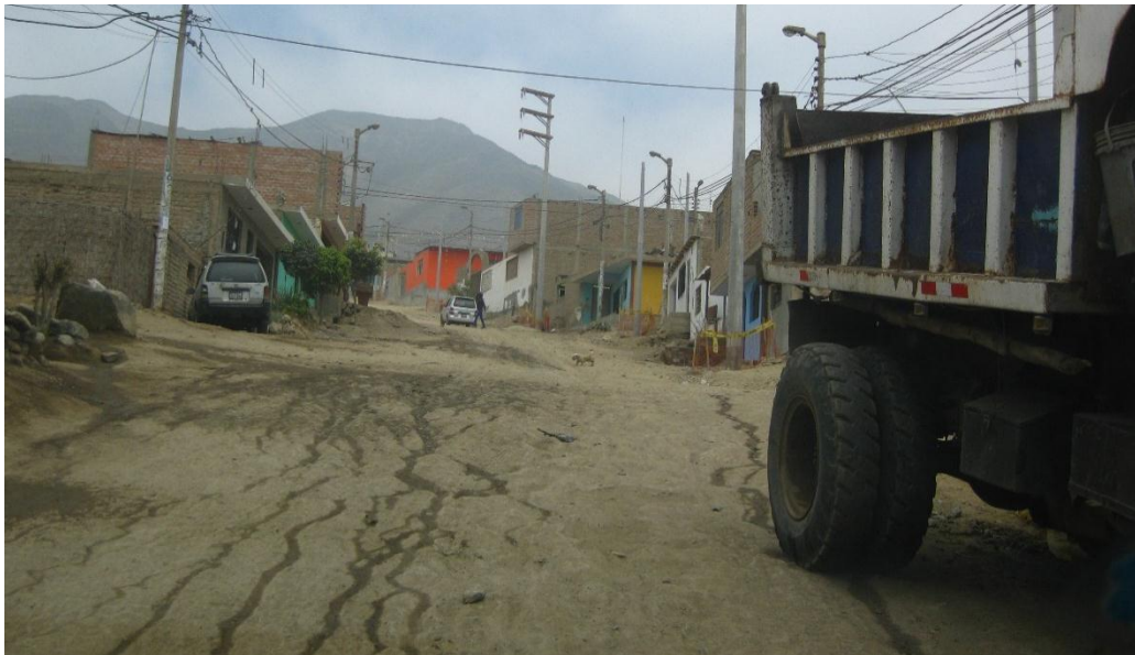
Foto N° 3.4.5.3.A Centro poblado El Ángel – Se observan la instalación de redes de energía eléctrica.
