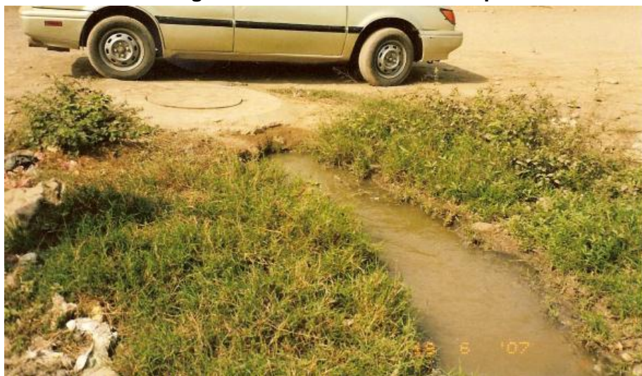
Foto N°3.3.12.1.B Derivación de aguas servidas antes de su disposición final
